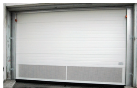
tablier avec panneaux isolants 40mm
