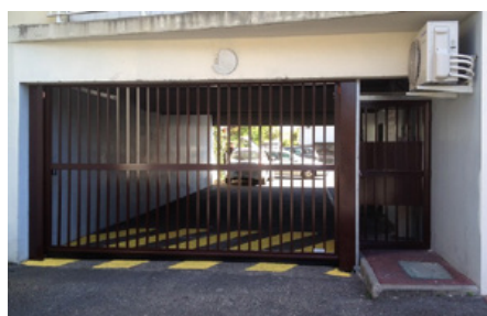
tablier en barreaux ronds, carrés ou losanges
