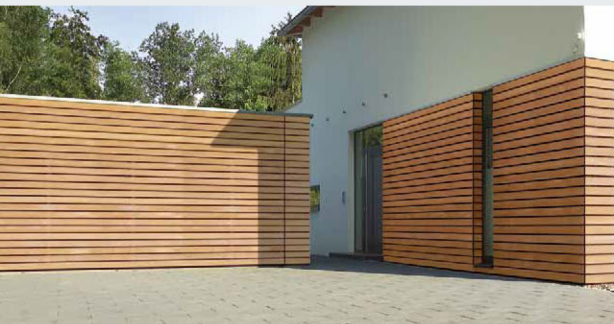
Parement par l'utilisateur avec panneaux en bois
